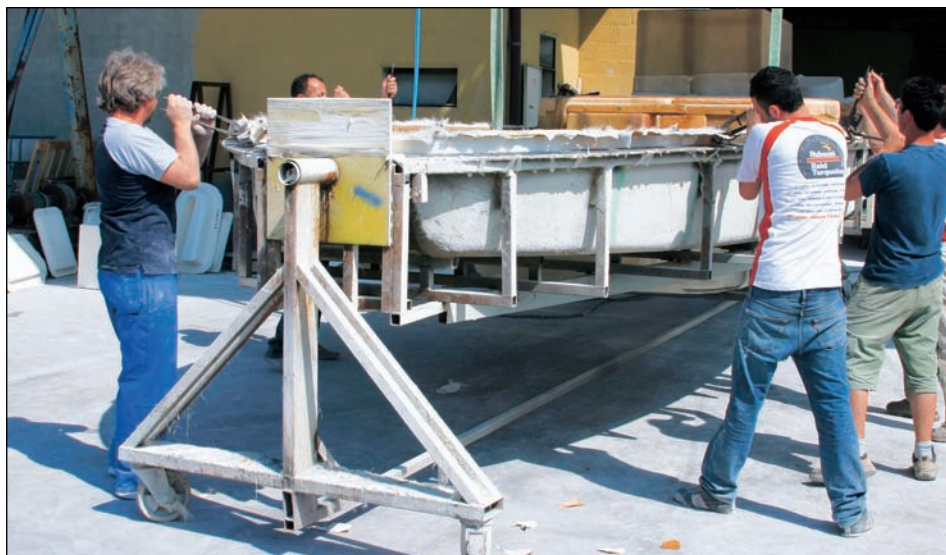
Vyjmutí hotové laminátové části z formy
